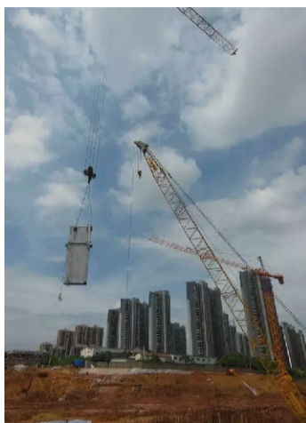
2017年6月9日，经过9个小时的连续浇筑作业，江北雅苑四期24#楼钢管束结构筏板基础浇筑工作顺利完成。
