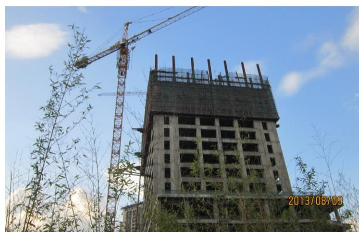
本报讯 8月10日，杭萧钢构项目部经过与众多困难的艰苦抗争，终于迎来了禧瑞都项目全面完工的胜利。该项目为钢骨结构制安工程，钢骨柱设计高度为地下13.2米，地上66米，总用钢量约为1200吨。
