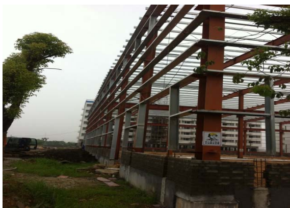
山墙次构件安装情况
