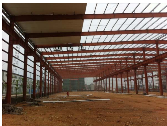
屋面内板安装
