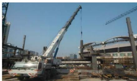
图 13 钢柱吊装图
