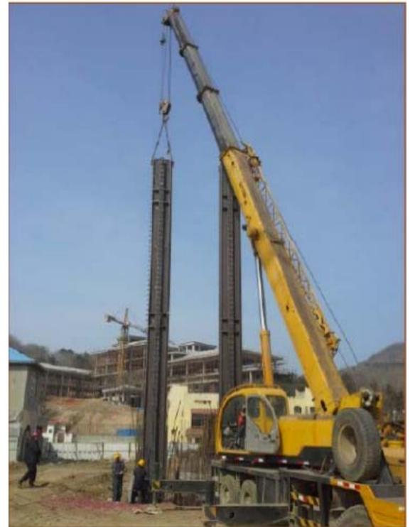
4月23日，由河北杭萧钢构有限公司承建的大连旅顺黄金山潜艇博物馆展馆A区钢结构工程正式开工建设，第一根钢骨柱的成功吊装，拉开了潜艇钢结构施工的序幕。
