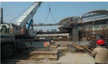
图 14 桁架吊装图
