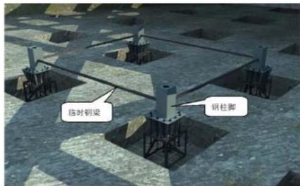
图2 一节柱钢柱支撑图
