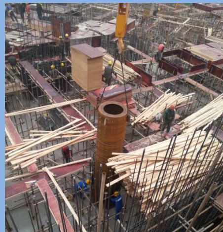
首节柱吊装就位
